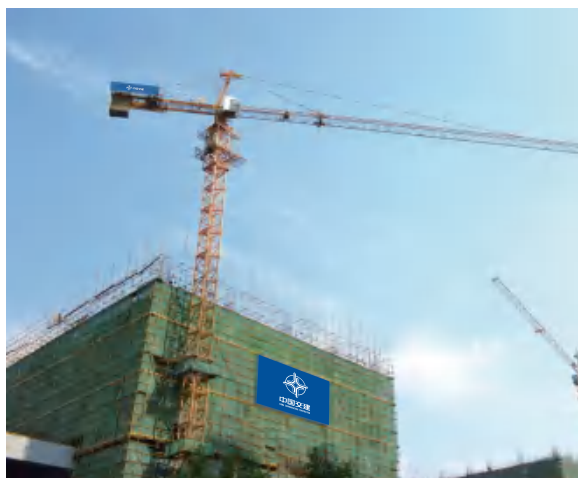
建筑楼面示例
