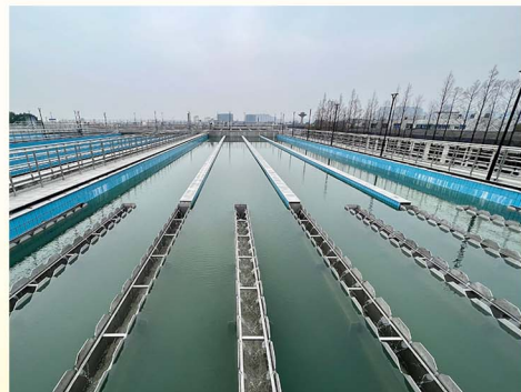
姚江工业水厂扩建工 程顺利完成联动调试并投 入试运营
