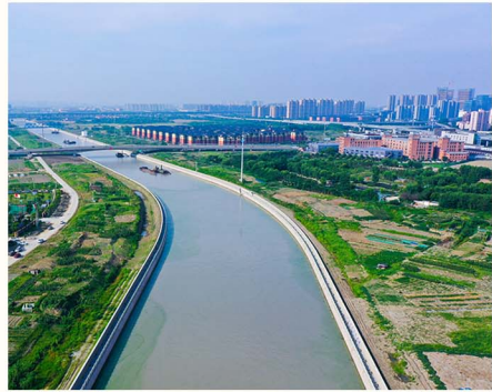
京杭运河二通道第 HDSG1-8标段航道、护岸、 服务区码头等单位工程通过 交工验收
